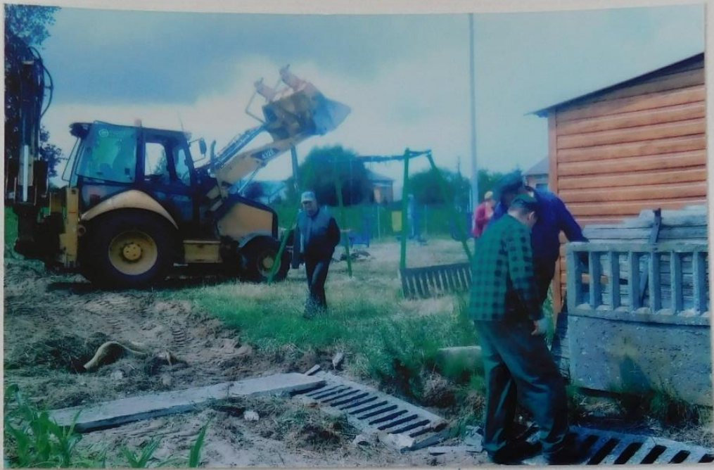
PRACE PORZĄDKOWE ORAZ ROZBIÓRKA PŁOTU PRZY ŚWIETICY WIEJSKIEJ. (fot. Dorota Łusztak) Rok 2015
