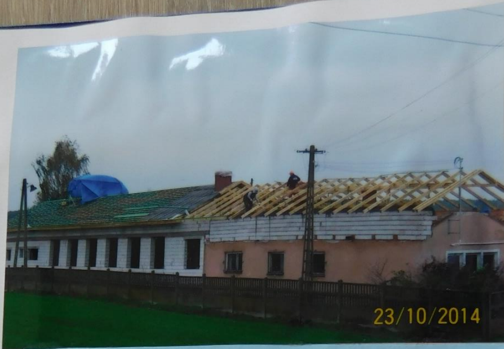
Budowa Świetlicy Wiejskiej i Strażnicy w Krępie (fot. Dorota Lusztak)
